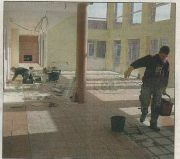
Noch gleicht der Innenraum einer Baustelle. Anfang November sollen hier die ersten Bewohner begrüßt werden.
